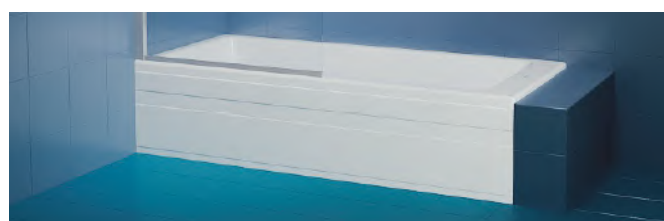
Figura 8- Retirar film protector del borde de la bañera a embutir. Embutir la bañera entre 1 cm. y 1,5 cm.
