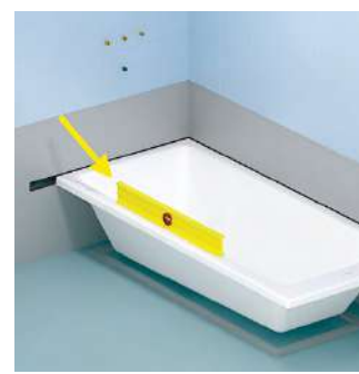
Figura 8- Retirar film protector del borde de la bañera a embutir. Embutir la bañera entre 1 cm. y 1,5 cm.
