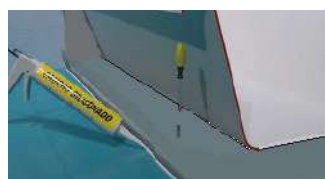
5- Colocar el caucho siliconado y fijar zócalo al piso mediante los tornillos provisorios.
