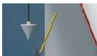
3- Realizar marcas en el piso en la posición de los agujeros del zócalo.
